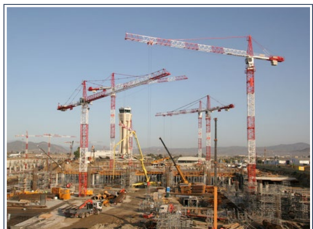
Figuur 13 Opstelplan met overlap van draaibereik per kraan en afbeelding van meerdere kranen op een bouwplaats
